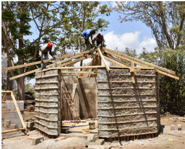
Links: Dachkonstruktion des kleinen Bomas erstellt von Abeid und seinen Handwerkern. Rechts: Wandarbeiten am grossen Boma durch Bablo und seine Arbeitergruppe.
