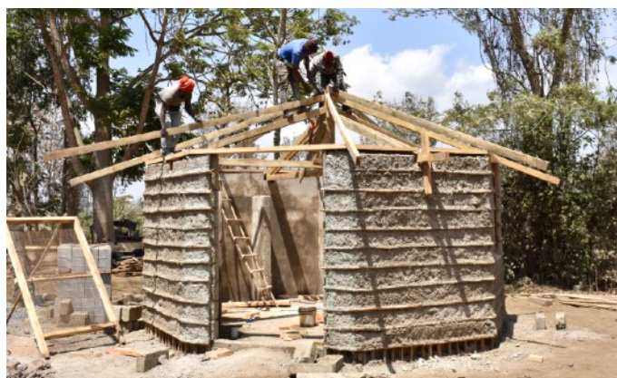
Abb. 4: Bedachung des ersten kleinen Bomas
