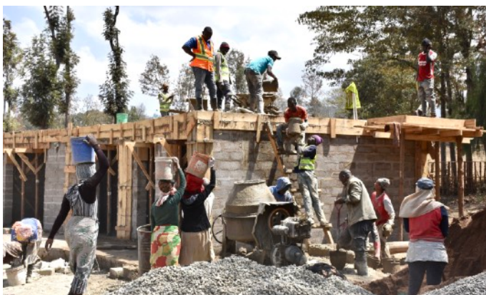
Abb. 3: Ausgiessen mit Zement des ersten Stockwerks des Wohnhauses
